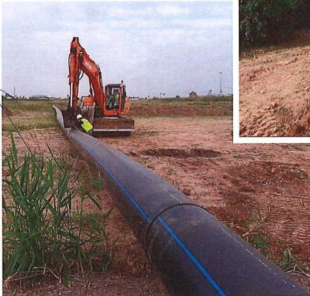
Consiguiendo una tubería continua, facilita su instalación por el interior de la funda bajo la carretera, sin riesgo de rotura ni fuga por manipulación, ya
